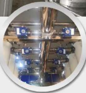
Su arıtma sistemlerinde kullanılan kollektörler sisteme uygun giriş ve çıkış çaplarında ve sayısında 304 ve 316 paslanmazdan imal edilmektedir. Besleme pompaları kollektörleri ve dağıtım hattı kollektörleri istenilen ölçüde ve malzemeyle imal edilmektedir. Argon gazlı kaynak yöntemi ile GMP'ye ve gıda normlarına uygun imalat yapılmaktadır.
